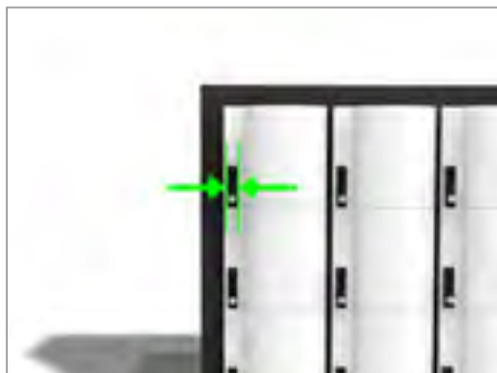
Exemple: Portes d'armoire bombées vers l'avant
